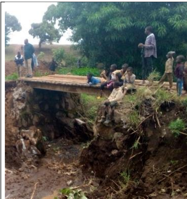
Picha: Kabla ya Ujenzi wa Daraja
